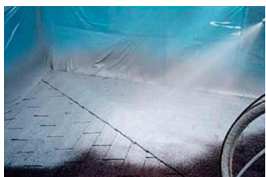
シングル屋根改修
