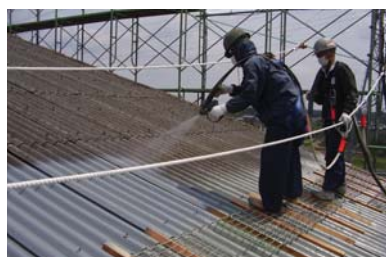
スレート屋根改修
