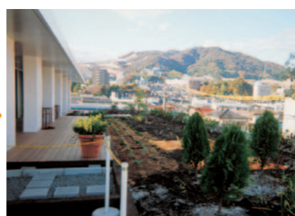
植栽施工完了
