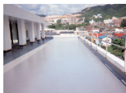
防水施工完了
